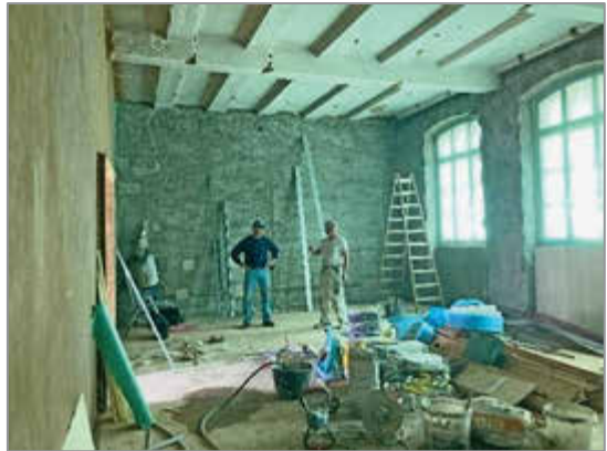
Der große Raum mit neuen Fenstern, links ist die Wand schon mit Lehmputz geputzt.
